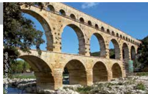
Rimski akvadukt stoji i danas: Pon di Gard u Francuskoj.
